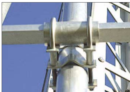
Bild 3: Detailansicht der Mastaufnahme mit Doppelschelle. Das ist während der Befestigung eine wacklige Angelegenheit. Die Hülse auf dem Boom sollte man zuvor arretieren.
